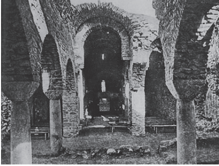
写真12 荒廃したサン・マルタン修道院
